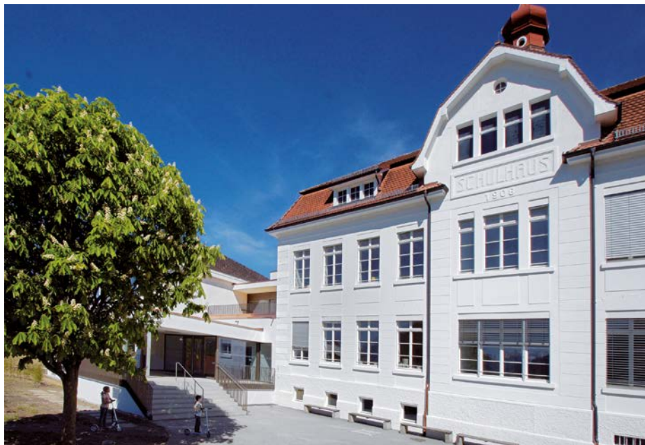
Die Volksschule wurde 2015 generalsaniert
